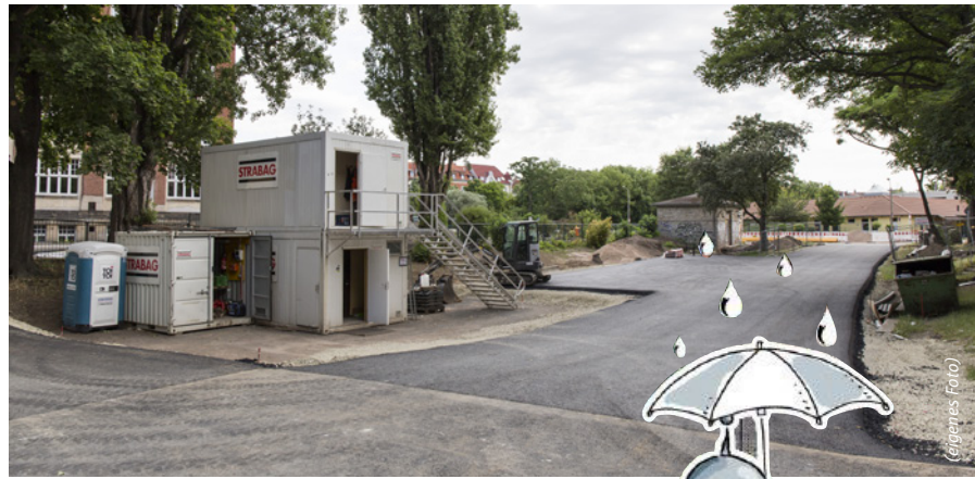
Die Baustelle wird in der Adalbertstraße eingerichtet Juli 2017
