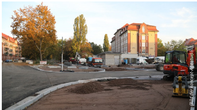
Der Straßen- und Wegebau kommt voran
