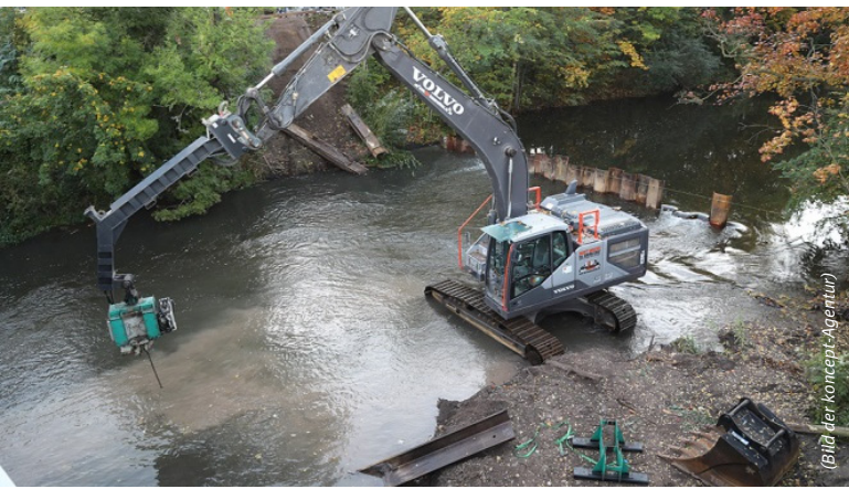
Provisorium für die Einrichtung des Dükers durch die Gera
