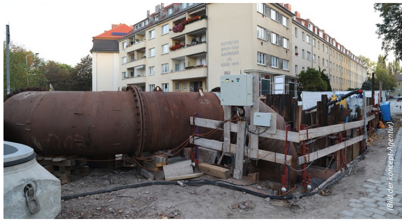
Provisorium zum Abwasserableiten auch oberhalb der Straße
