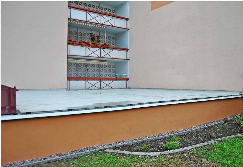
Fertiggestellt: Konnexdach Lowetscher Straße 66/67
